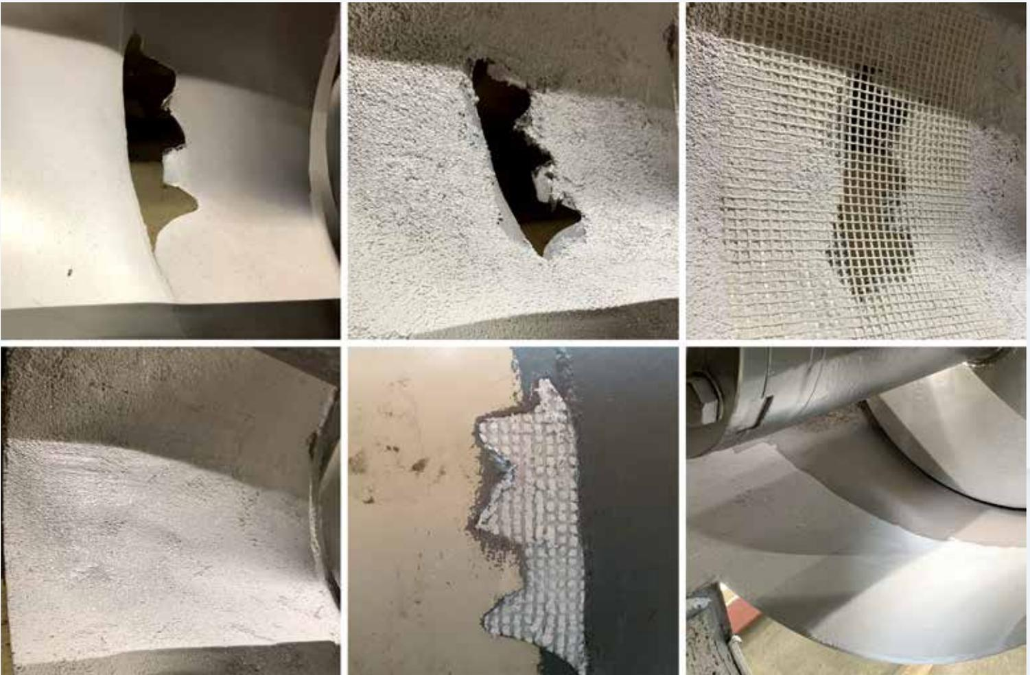
**Abrasionschutz - Holzspäne/Staub mit hoher Geschwindigkeit**
